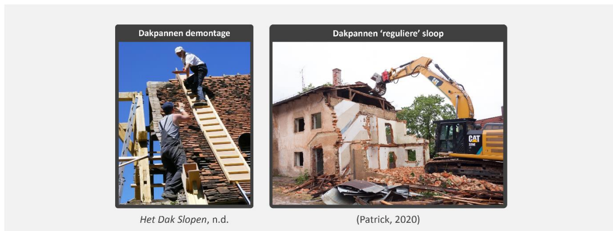
afbeelding 7 Demontage en reguliere sloop van dakpannen
